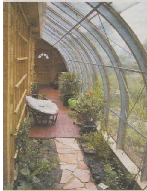
Ein Konzept, mit dem man Umweltpreise gewinnt: Die Glashülle des Bio-Hauses bewirkt, dass die Holzwände warm bleiben.
