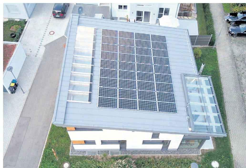
Luftaufnahme von Photovoltaikanlage und Pultdach
